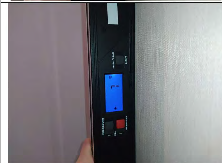
Фото №8. Измерение уровня стен в прихожей.
