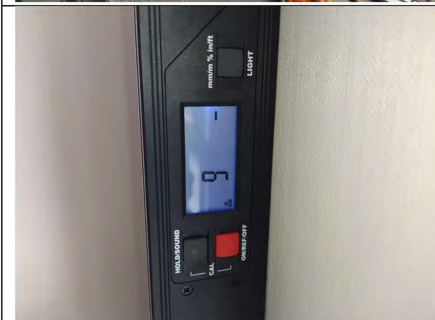
Фото №6. Измерение уровня стен в спальне.
