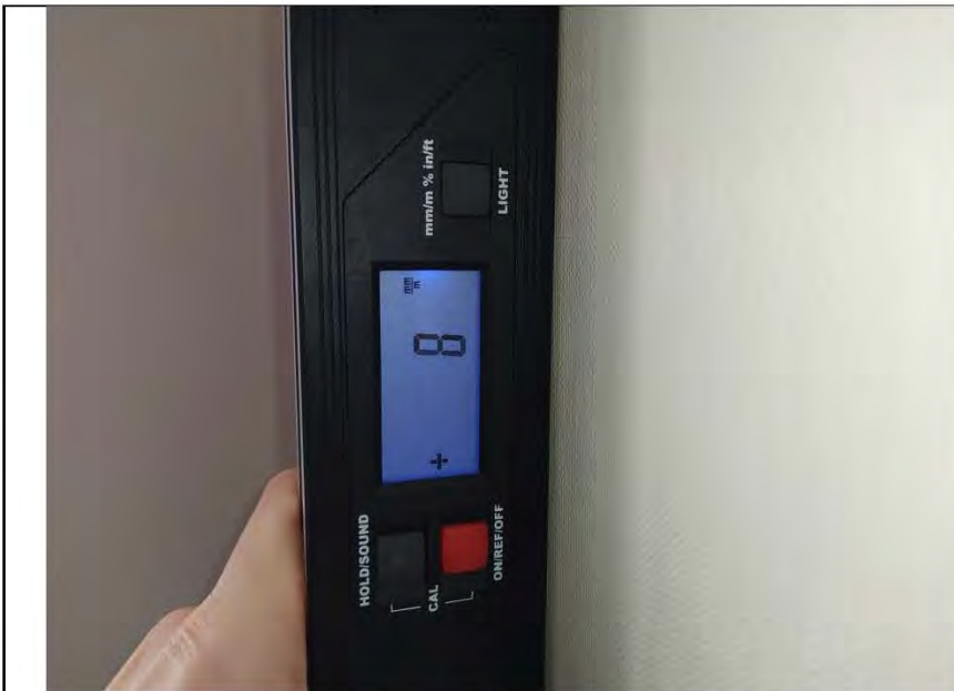
Фото №7. Измерение уровня стен в кухне.
