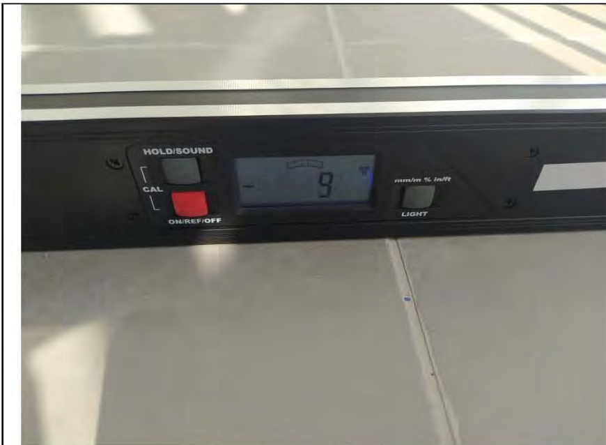
Фото №16. Измерение уровня напольного покрытия на лоджии (керамическая плитка).
