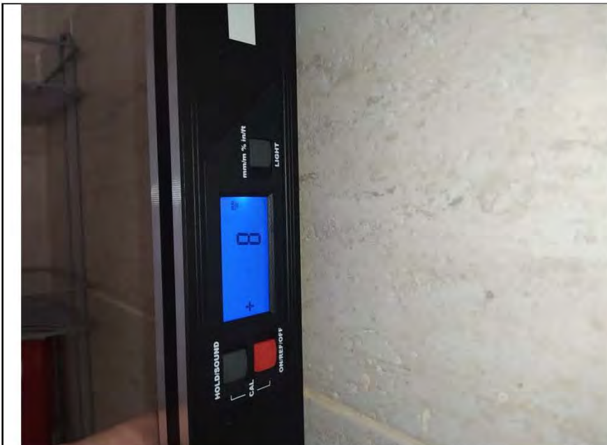
Фото №10. Измерение уровня стен в ванной комнате (керамическая плитка).
